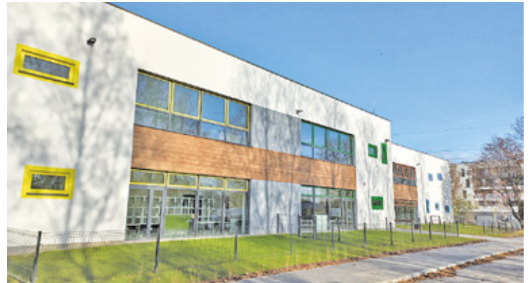
Nowy budynek przedszkola nr 8
