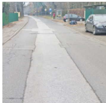
Ulica Wojska Polskiego jest na liście ulic, które mają być remontowane za środki zewnętrzne z Polskiego Ładu
