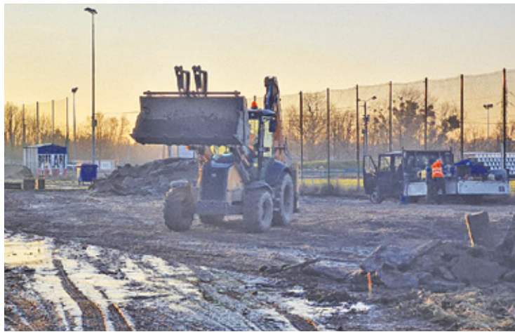
Wykonawca skateparku dokonał już demontażu starej powierzchni placu
