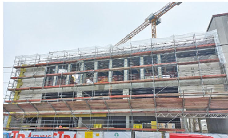
Budowa nowego budynku
