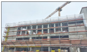
||| Pruszków - Wiecha na dachu s. 4
