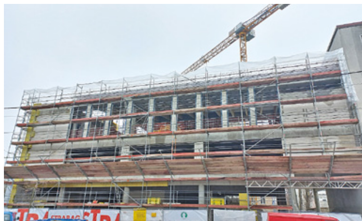
Budowa nowego budynku
