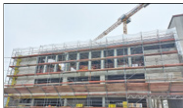
||| Pruszków - Wiecha na dachu s. 4
