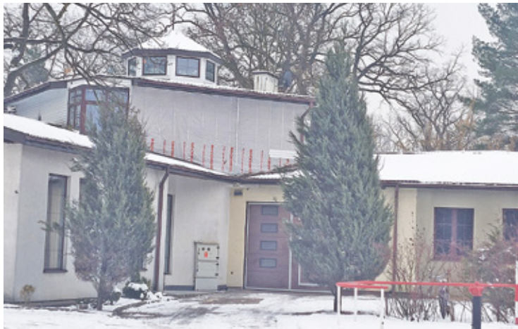
Niedługo stara siedziba OSP zniknie, a na jej miejsce powstanie nowy budynek, w którym będzie się mieścić Milanowskie Centrum Bezpieczeństwa
