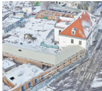
Prace są coraz bardziej zaawansowane
