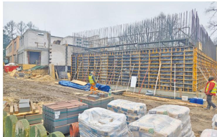
Po rozbudowie szkoła w Skułach zapewni uczniom wysoki standard nauki
