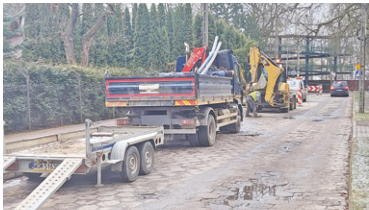
Na ulicy Żabie Oczko prowadzącej do wyremontowanej niedawno szkoły podstawowej trwa obecnie wymiana wodociągu
