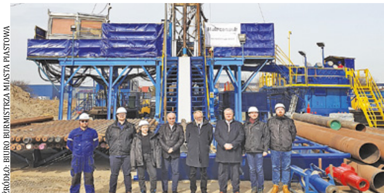
Źródło: Biuro Burmistrza Miasta Piastowa Budowa jest przygotowana do odwiertu
