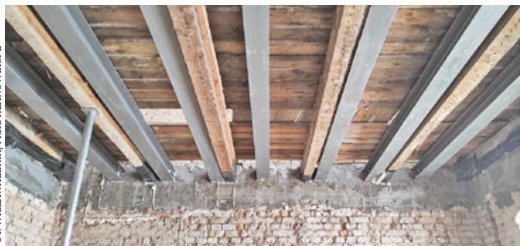
Trwa wykonanie wieńca na ścianach wewnętrznych oraz prace związane z wzmocnieniem stropu między parterem a piętrem
