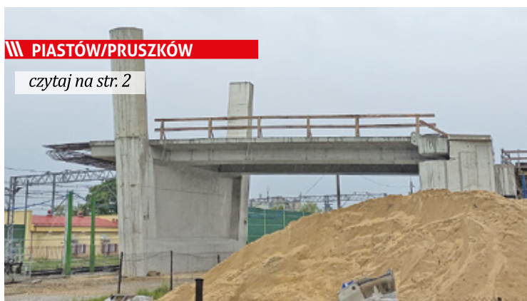
Wiadukt w budowie
