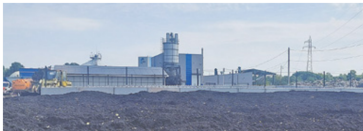
Budynki funkcyjne oczyszczalni to m.in. fermentery, w których osad jest stabilizowany i przepompowywany do stacji odwadniania i zagęszczania
