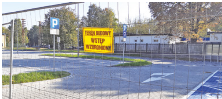
Parking P&R przy ulicy Pawiej w Pruszkowie wciąż jest placem budowy
