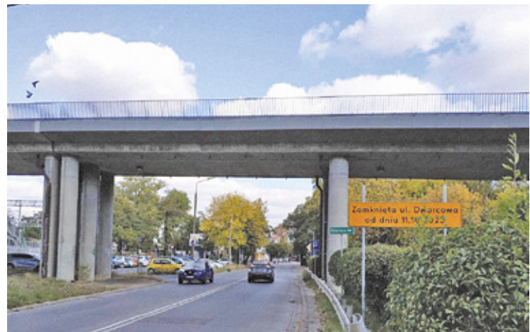
Stara kanalizacja przy ulicy Dworcowej nie spełnia swojej funkcji
