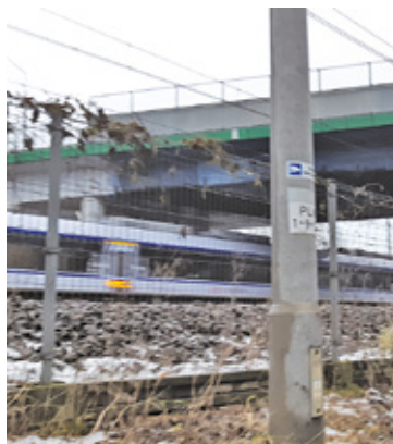
Wiadukt nad torami PKP będzie zburzony, powstaną dwie przeprawy
