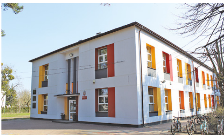
Termomodernizacja Szkoły Podstawowej nr 1
