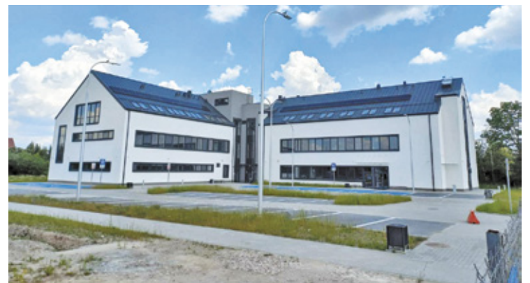
Budowa placówki jest niemal zakończona
