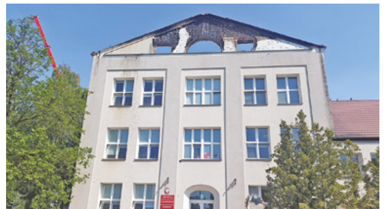
Zewnątrz ślady pożaru, jaki wybuchł tu w czasie matur
