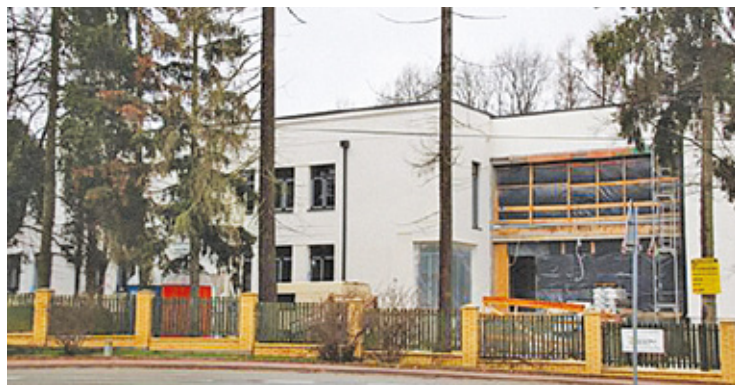
Rozbudowa szkoły podstawowej w Skułach
