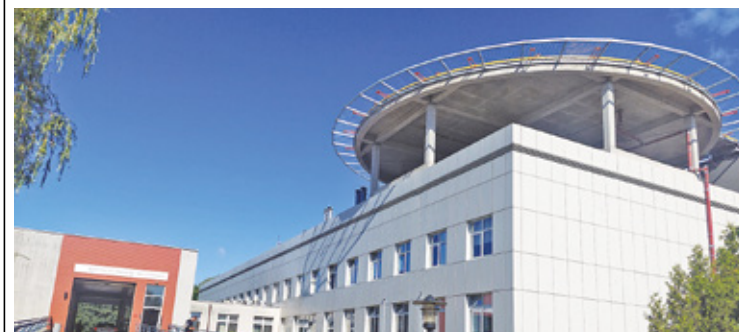
Lądowisko znajduje się na dachu szpitala, nad SOR-em
