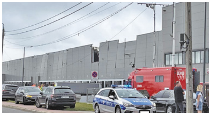
Poważne uszkodzenia wyłączyły obiekt z bieżącego użytkowania
