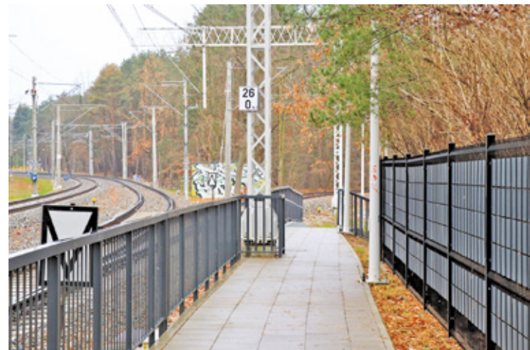
W ramach projektu powstało bezpieczne zejście o łagodnym nachyleniu
