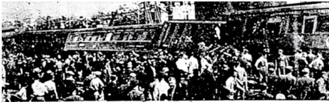
Na miejscu wypadku. Pierwsze dwa wagony są konstrukcji stalowej — polskiej, wagony oznaczone na (X) — austriackie.
