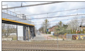
||| Pruszków - Powstanie przejście pod torami s. 5
