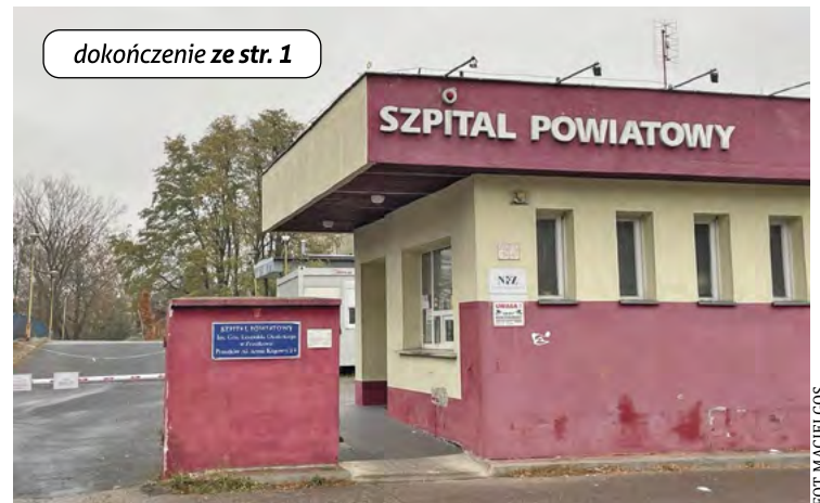
Nowy budynek będzie parterowy. To znacznie ułatwi pracę personelu zakładu, a także będzie wygodniejsze dla samych pacjentów
