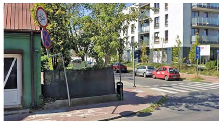
Powiększenie chodnika na rogu ulic Armii Krajowej i Komorowskiej ma zwiększyć bezpieczeństwo i komfort poruszającym się pieszym w tym miejscu
