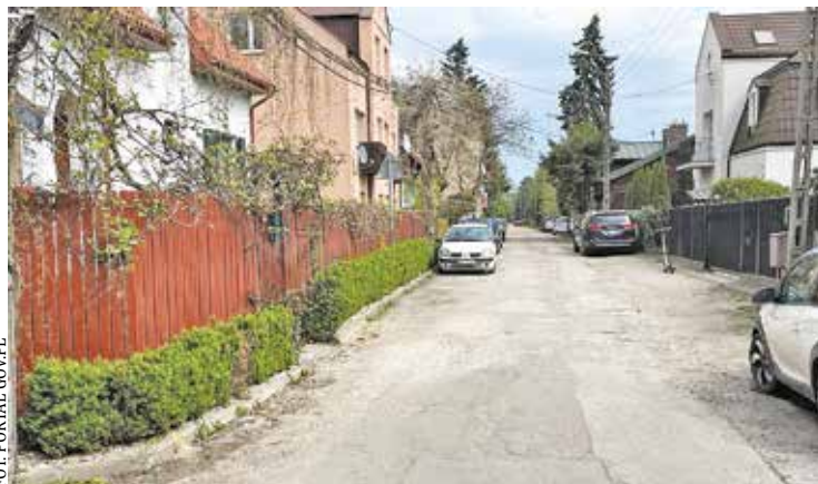
Obie ulice wymagają pilnej przebudowy
