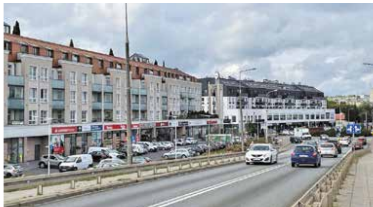
Pierwsza faza nowego projektu obejmie stworzenie projektu instalacji 54 kamer w 24 miejscach. Zostanie on zrealizowany jeszcze w tym roku
