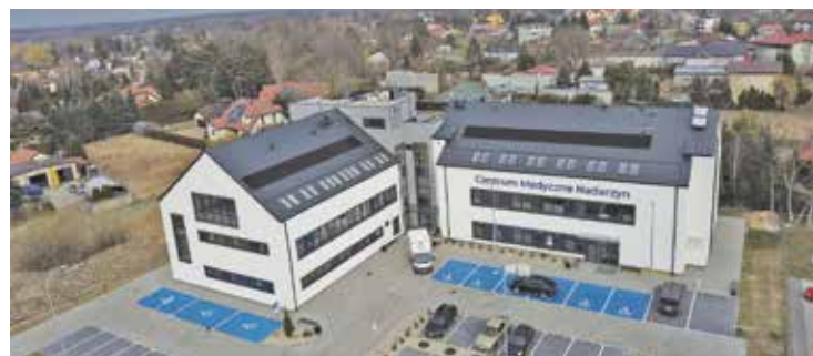
W ostatnim czasie trwały prace wykończeniowe, a już za kilkanaście dni będziemy mogli korzystać z usług nowoczesnej przychodni
