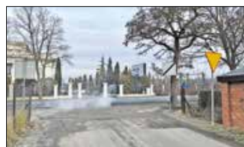
/// Brwinów - Przebudowa skrzyżowania
