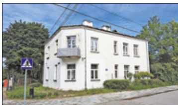
/// Milanówek - Remont budynku komunalnego s. 2
