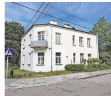
Budynek komunalny przy ulicy Wojska Polskiego 85 przed termomodernizacją
