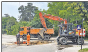
/// Brwinów – Remont ul. Leśnej s. 7
