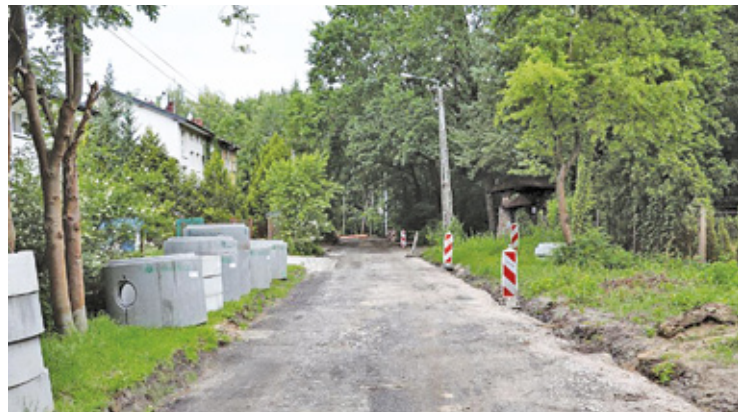
Prace remontowe już się rozpoczęły
