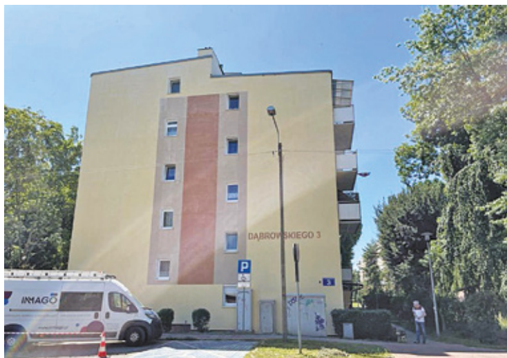
Elewacja po odświeżeniu
