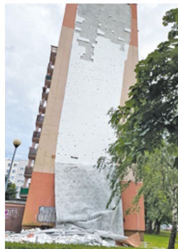
Elewacja odpadła od ściany bloku
