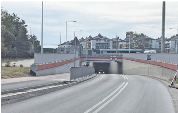
Urząd miasta wyznaczył objazd przez wiadukt nad torami w ciągu ul. Poznańskiej i przejazd kolejowy na ul. Przejazdowej
