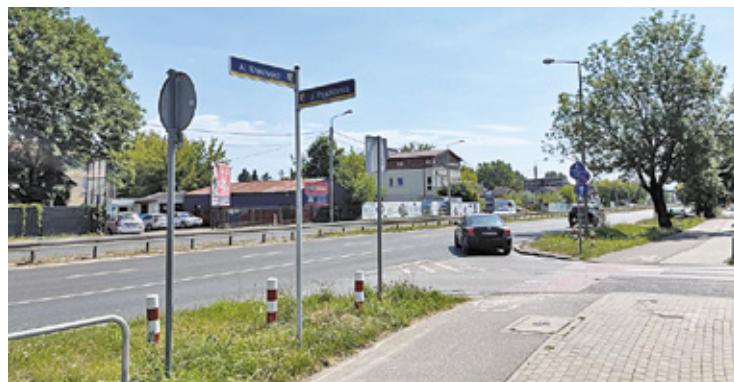
Skrzyżowanie, chodniki i zjazdy zostaną dostosowane do nowego układu drogowego. Zostanie też zainstalowana nowoczesna sygnalizacja świetlna
