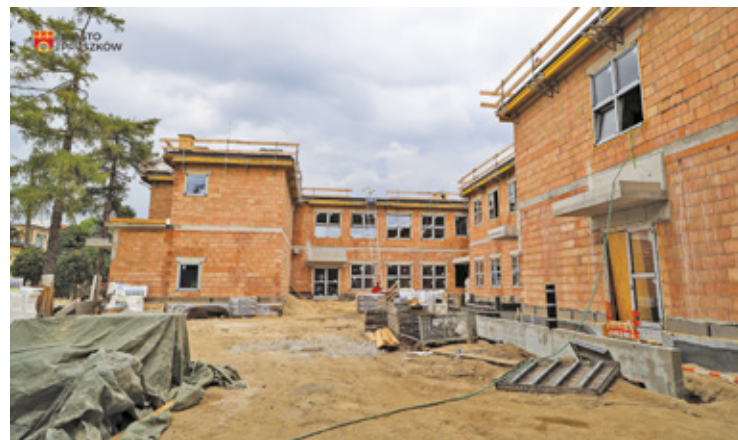
W 2026 roku kontynuowane będą kolejne etapy budowy, by we wrześniu przyszłego roku nowoczesne przedszkole mogło otworzyć swoje drzwi dla 200 dzieci
