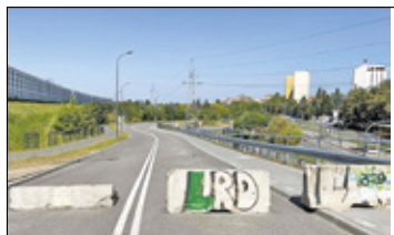
/// Piastów - Kiedy most będzie przejezdny?
