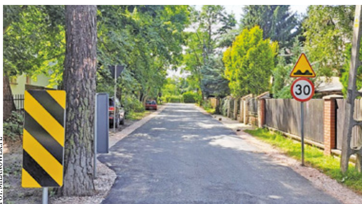
W ramach inwestycji wykonano nową nawierzchnię bitumiczną oraz pobocza z kruszywa
