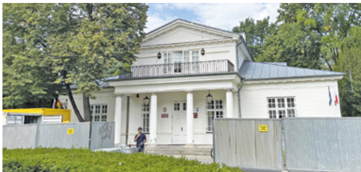
Prace potrwać około dwa miesiące
