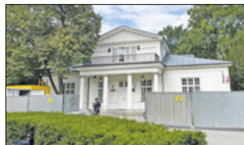
/// Pruszków - Remont Pałacyku Potulickich
