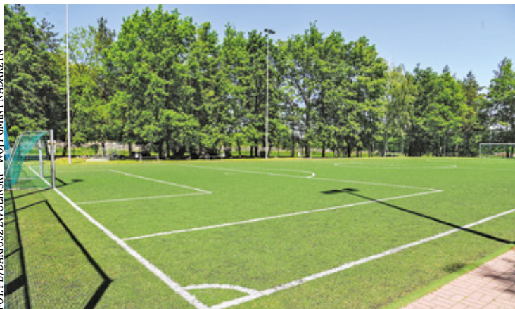
Prace mają rozpocząć się w przyszłym tygodniu, a ich zakończenie zaplanowano na koniec października 2025 roku
