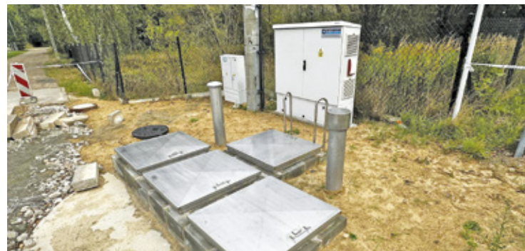
Nowe przepompownie ścieków w gminie Nadarzyn to pierwszy krok do modernizacji oczyszczalni i ochrony rzeki Zimna Woda
