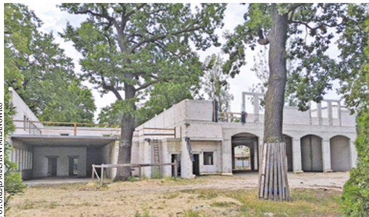
Milanówek ogłasza przetarg na budowę strażnicy dla OSP
