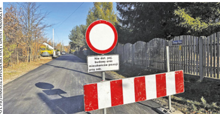
Odtwarzanie nawierzchni po budowie kanalizacji w Starej Wsi
