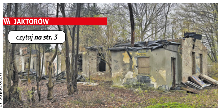
/// JAKTORÓW czytaj na str. 3 Ruiny dawnego budynku doktora Skoryny w Chylicach-Kolonii – obiekt, którego wpis do rejestru zabytków wywołał burzę w Jaktorowie
