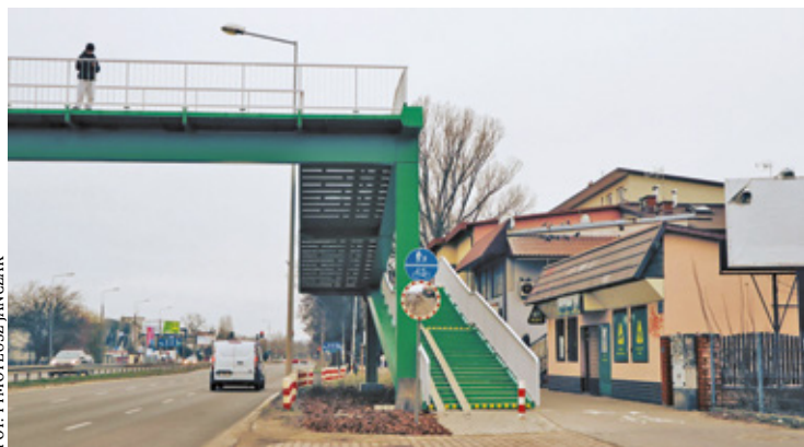
Odświeżenie konstrukcji i wprowadzenie elementów antypoślizgowych ma zmniejszyć ryzyko wypadków
