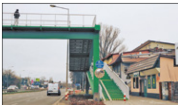
/// Raszyn - Kładka otwarta s. 4
