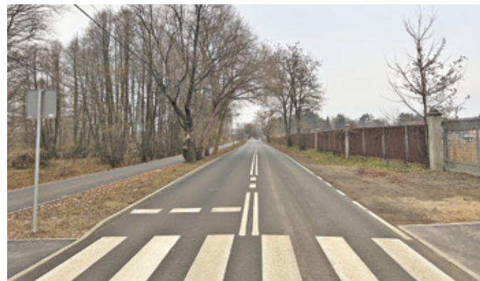
Droga powiatowa 1523 – ulica Brwinowska w Milanówku
