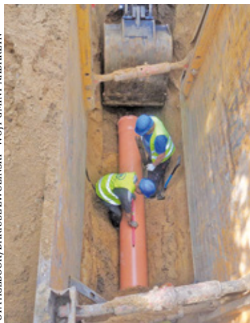
Do nowej infrastruktury przyłączy się aż 355 posesji
