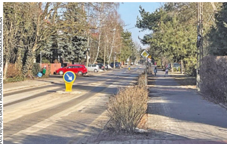
Remont ulic Podhalańskiej i Ireny w Komorowie – inwestycja obejmuje nową nawierzchnię jezdni oraz drogę dla pieszych i rowerów o długości ponad kilometra
