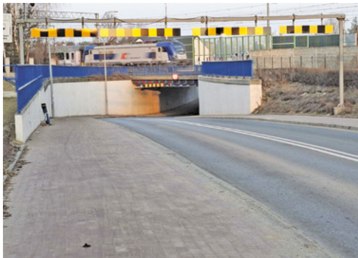
W tunelu pod torami na ul. Bałtyckiej w Grodzisku Mazowieckim często dochodzi do poważnych wypadków
