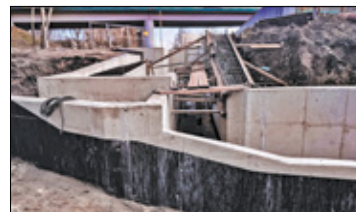
/// Pruszków – Prace przy przejściu pod torami PKP s. 5
