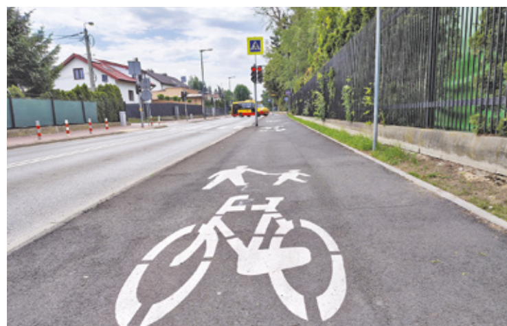
Ścieżka rowerowa przy ul. Montwiłła w Grodzisku Mazowieckim
