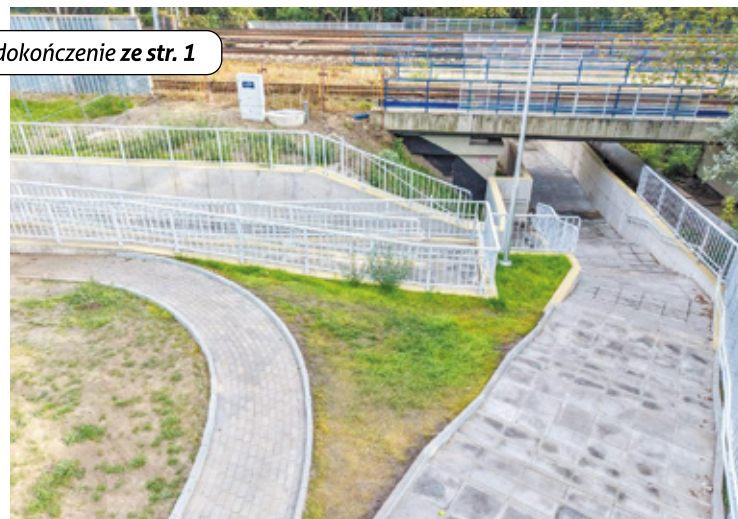
FOT. MIASTO PRUSZKÓW
