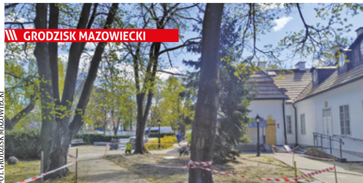
FOT. GRODZISK MAZOWIECKI Remont zakładu szereg działań – między innymi poprawki na dachu i odnowienie elewacji
