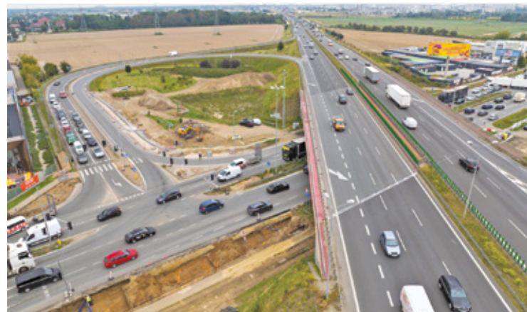
Węzeł Warszawa Zachód na trasie S8, w rejonie skrzyżowania z DK 92
