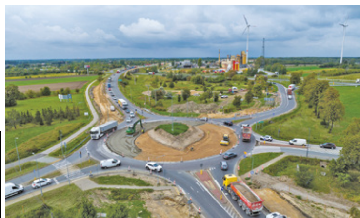
Przebudowa ronda na węźle Mszczonów S8 w związku z rozbudową A2 Łódź-Warszawa
