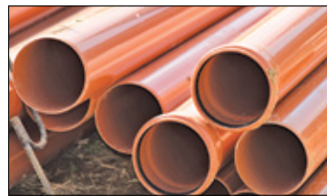
Brwinów - Budowa kanalizacji w Kaniach s. 6
