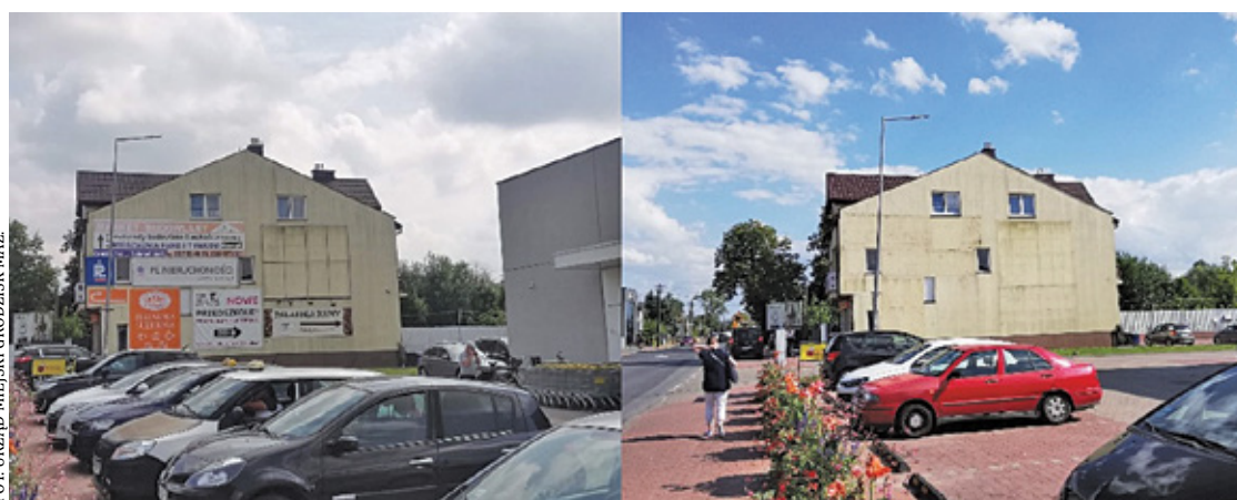
Zdjęcie, które zachęca do przyjęcia Uchwały, gdyż pokazuje fasadę budynków przeladowaną szyldami i banerami reklamowymi, które są wyblakłe, zniszczone lub tandetne
