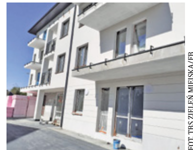
Budynek przy Zakątnej 2 powinien być gotowy do końca czerwca
