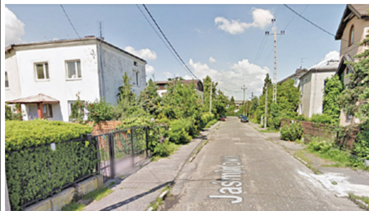
Nawierzchnia ma ulec poprawie
