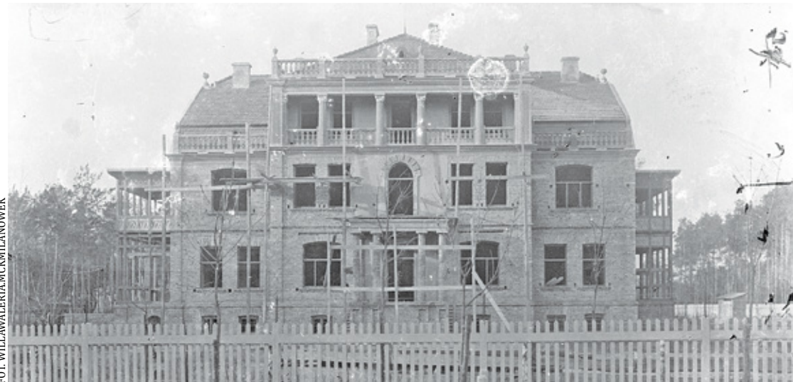
Willa „Waleria” podczas budowy
