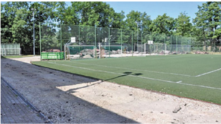
Prace obejmują bazę sportową
