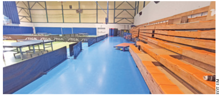
Tak wyglądała hala przy Westfala przed modernizacją
