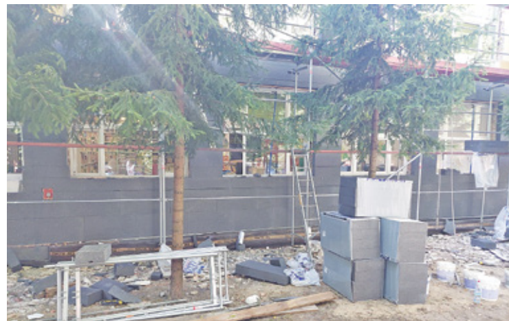
Prace nad ociepleniem kolejnych ścian nadal trwają
