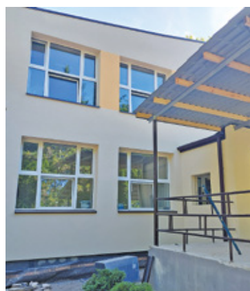
Ocieplenie elewacji przy głównym wejściu jest już zakończone
